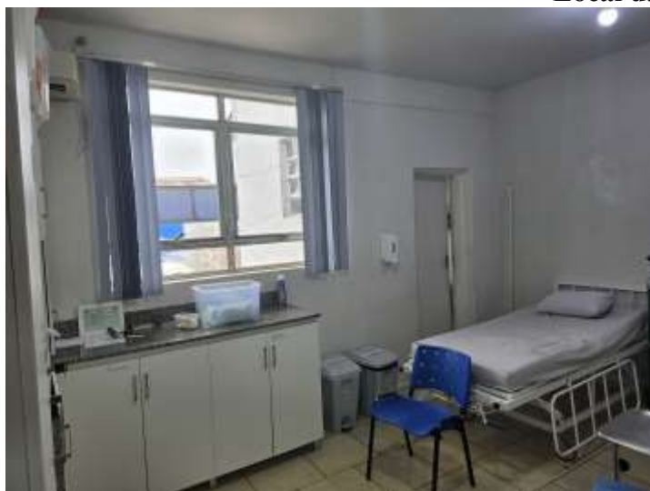
Local da Janela que será aberto
