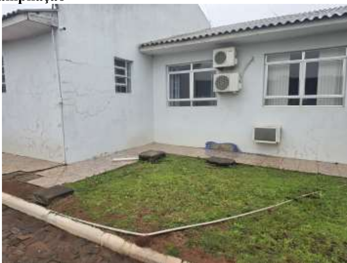
Construção da Ampliação
