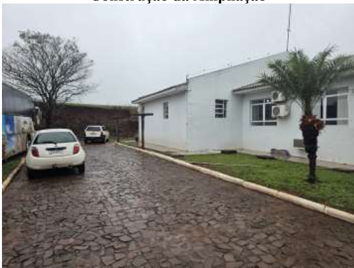
Construção da Ampliação
