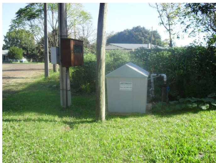
Imagem 17- estrutura existente onde é feita a adição de flúor e outros aditivos.
