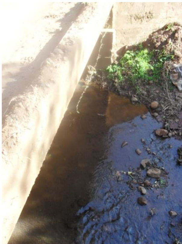
Imagem 33- Ponte localizada nas coordenadas -28^{\circ}48'53''/-53^{\circ}27'29'' , na localidade do Anexo C Observa-se a presença elevada de sedimentos, sendo necessária a realização de manutenção e limpeza (continuação).
