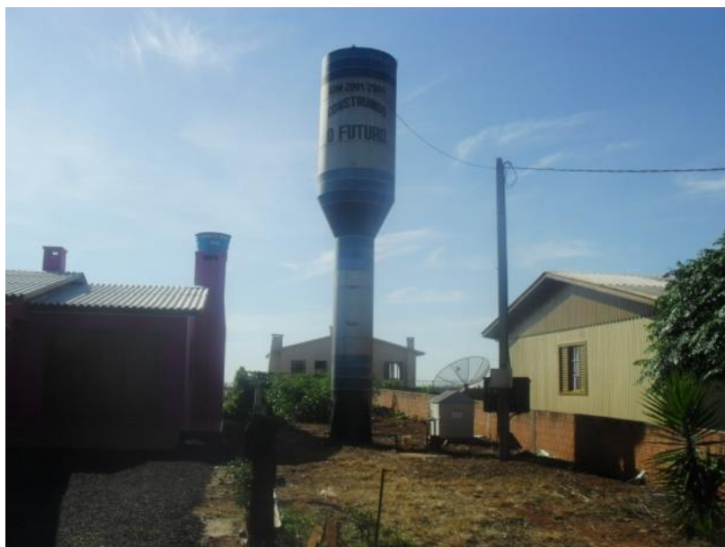
Imagem 19- Reservatório existente no endereço Lucia Barbosa, com capacidade de 15000 l.
