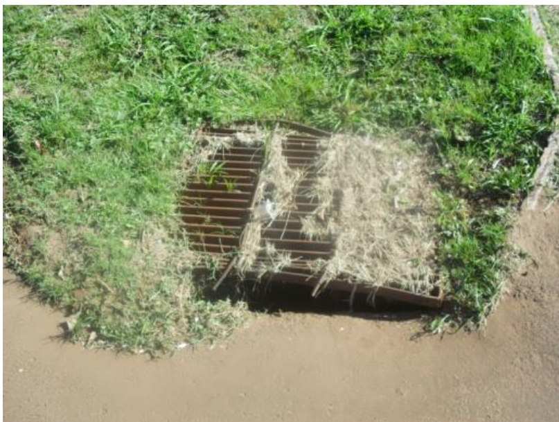
Imagem 26- Sarjetas, bocas de lobo e grelhas existentes no município que compõem o sistema de microdrenagem.
