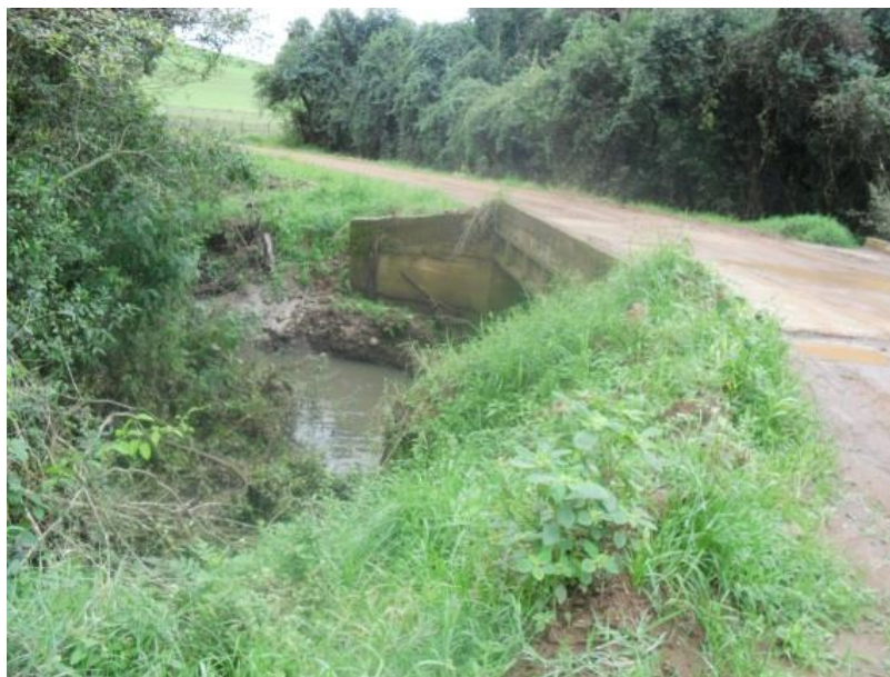
Imagem 35- Ponte em condições de trafegabilidade, contendo cabeceira e prancha, localizada na -28^{\circ}50'44''/-53^{\circ}22'15'' , na estrada principal da Fazenda da Lagoa.
