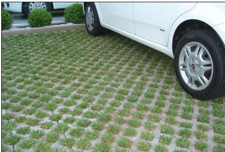
Imagem 41- Exemplo de pavimento poroso (bloquetes vazados). Fonte: Inova Consultoria Ambiental.
