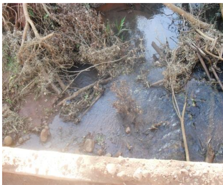
Imagem 32- Ponte localizada nas coordenadas -28°48`53”/-53°27`29”, na localidade do Anexo C Observa-se a presença elevada de sedimentos, sendo necessária a realização de manutenção e limpeza. Fonte: Prefeitura Municipal De Boa Vista do Incra.
