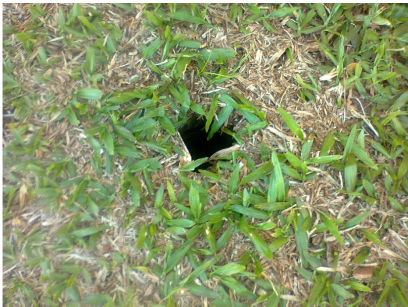
Imagem 21- Poço negro instalado em área residencial, sistema utilizado para a disposição final dos efluentes, sem previsão de tratamento.
