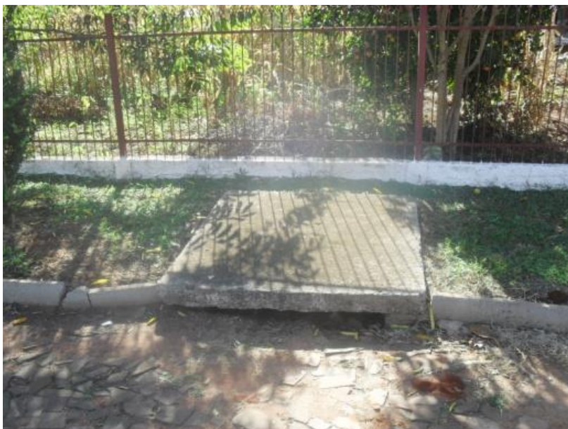
Imagem 27- Sarjetas, bocas de lobo e grelhas existentes no município que compõem o sistema de microdrenagem (continuação I).
