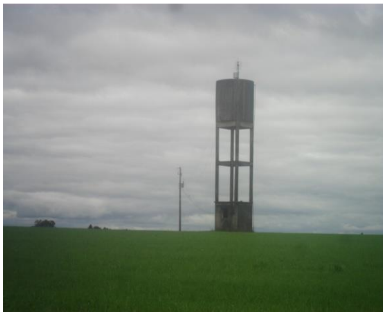
Imagem 20- Reservatório existente no endereço Anexo C, com capacidade de 30000 l. Fonte: Prefeitura Municipal De Boa Vista do Incra
