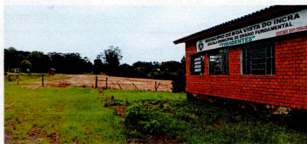
Foto 03 Local junto a escola, cercado por áreas agrícolas/ local plano a suavemente ondulado.
